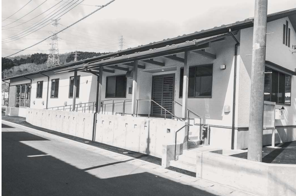
入口にはスロープも設置されました
